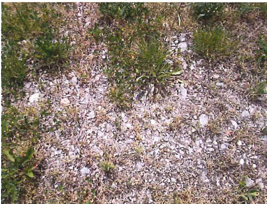
Abb. 18: Angrenzend an das Bauwerk vorliegender Platz mit wassergebundener Decke
