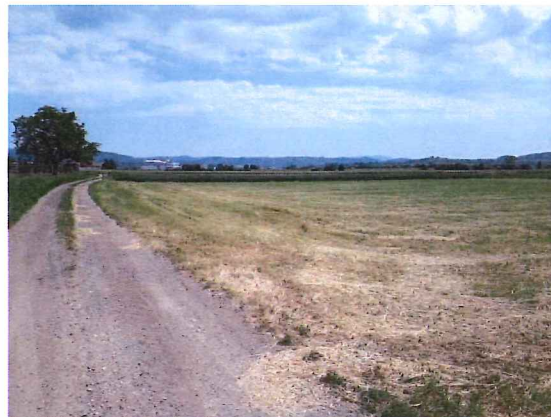
Abb. 19: Verbindungsweg (Ost-West) mit wassergebundener Decke und teilweisem Pflanzenwuchs
